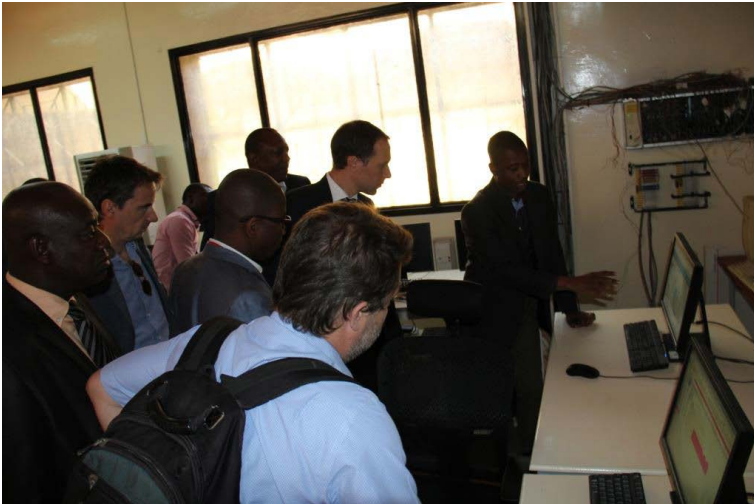
Salle de télécommunication
