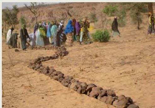
Construction des cordons pierreux
