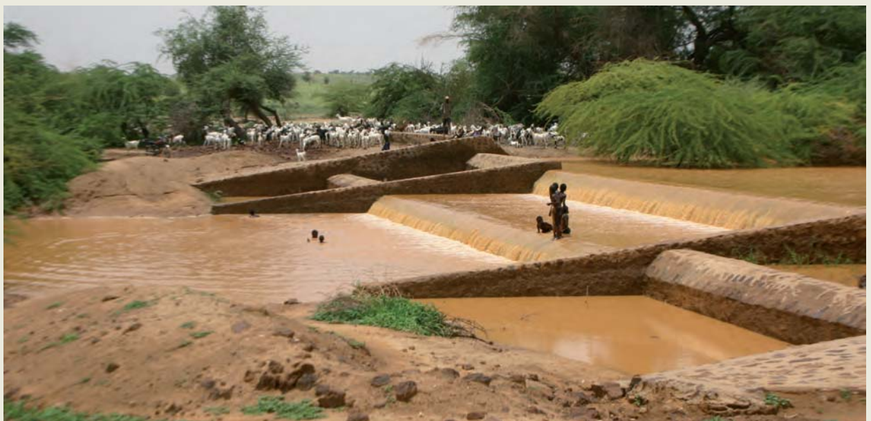
Déversoir d'un seuil d'épandage
