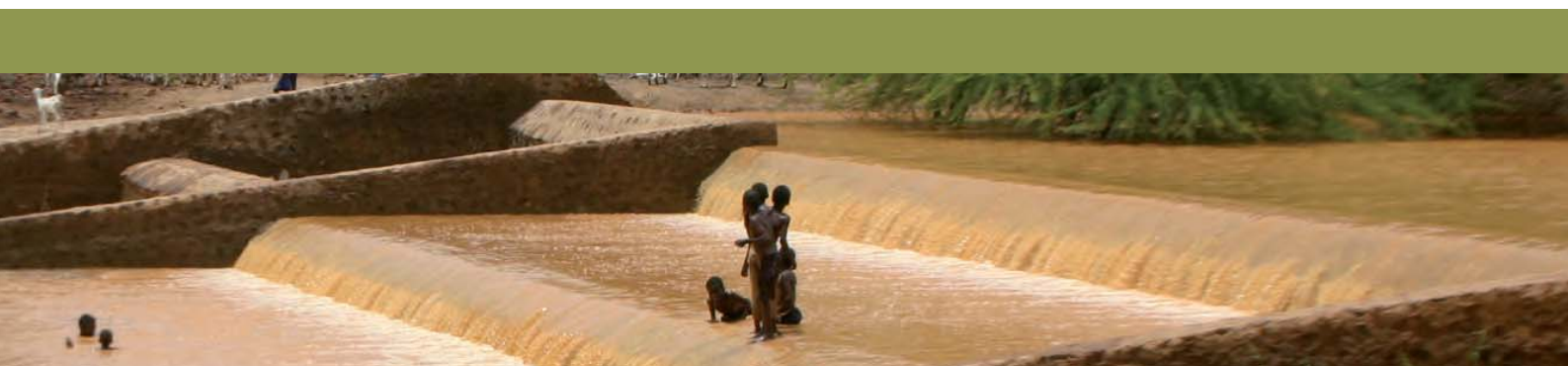
Les seuils d'épandage ont plusieurs utilisations
