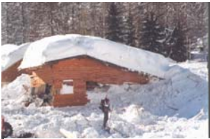
Catastrophe de Montroc, 9 février 1999, chalet détruit et déplacé
