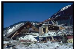
Maison détruite par une avalanche aérosol (38)
