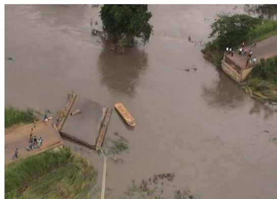
**Figure 3** : Rupture du pont sur la route nationale N°1 à AMAKPAPE suite aux inondations d'août 2008
