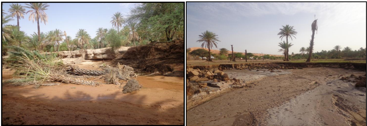
Photo 6 : Dégâts causés par les inondations de 2013 dans les oasis de l'Assaba.
