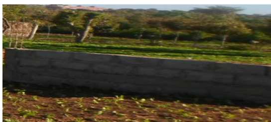
Photo 5: Construction d'un petit mur
