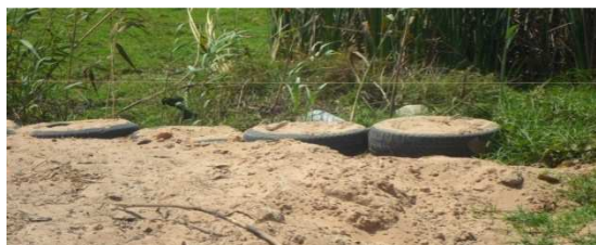
Photo 3: Remblai de pneus
