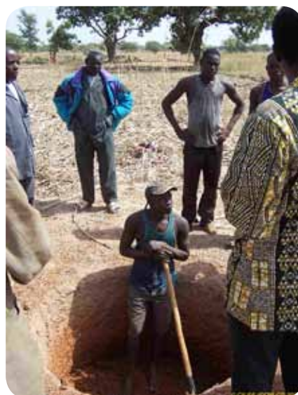
Construction d'un puits
