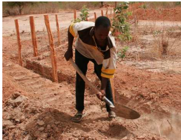
Photo 27 : rebouchage de la tranchée
