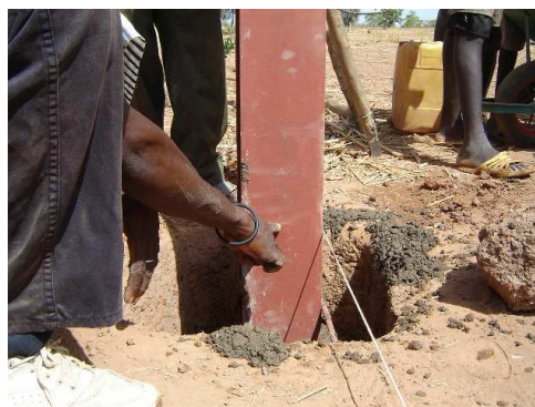
Photo 1 : alignement du poteau
