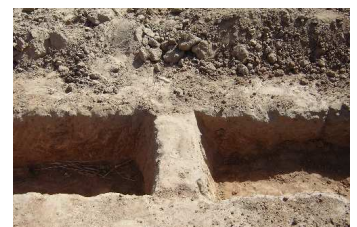
Photo 12 : aspect d'une cale une fois la tranchée creusée
