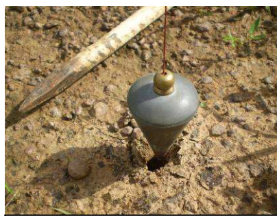
Pour une route : le plomb est centré sur le trou créé par un piquet (photo 4).
