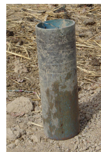
Photo 16 : gabarit pour les trous de piquets
