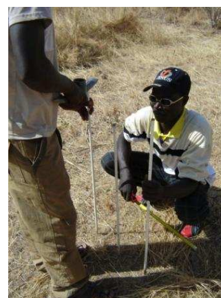
Photo 9 : piquetage de la largeur de la tranchée
