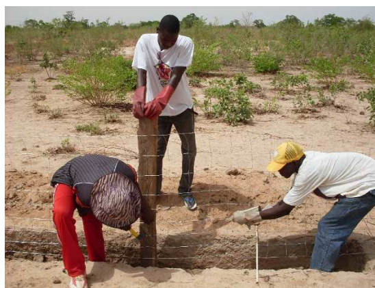
Photo 24 : pose des crampillons
