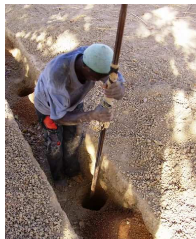
Photo 18 : creusage des trous de la tranchée
