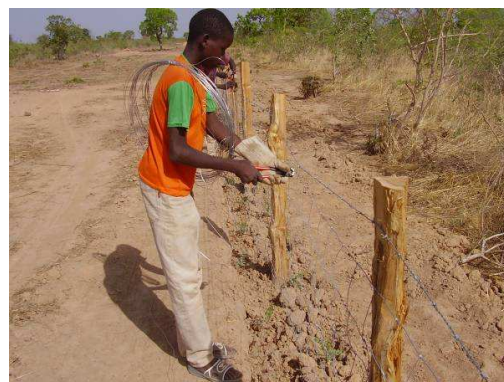
Photo 26 : fixation grillage/barbelé
