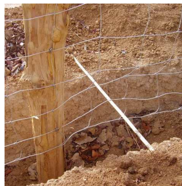
Photo 23 : piquet guidant la pose du grillage
