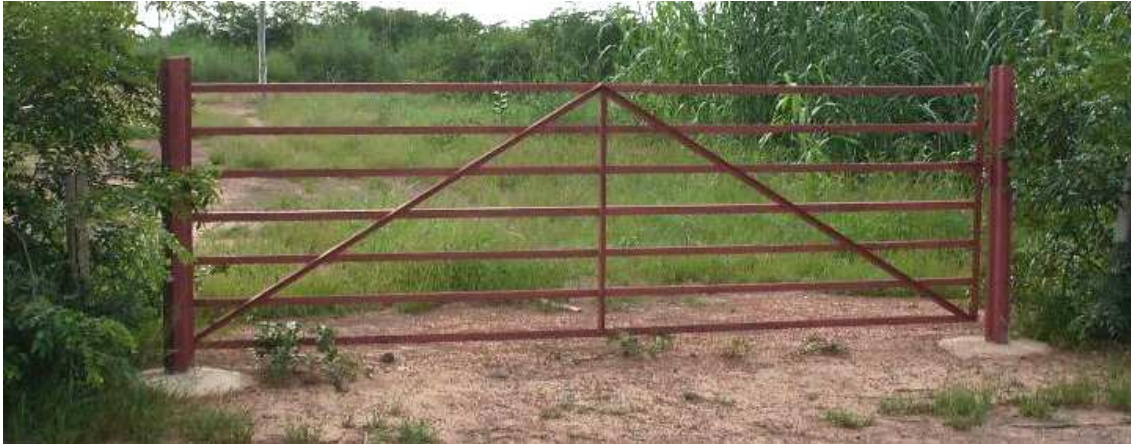
Photo 19 : exemple de porte barrière
