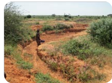
Photo 4 : Aménagement de demi-lune anti-érosive de grand diamètre (20 m) à Thiès (Sénégal)
