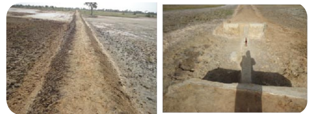
Photo 4 : Aménagement de demi-lune anti-érosive de grand diamètre (20 m) à Thiès (Sénégal)
