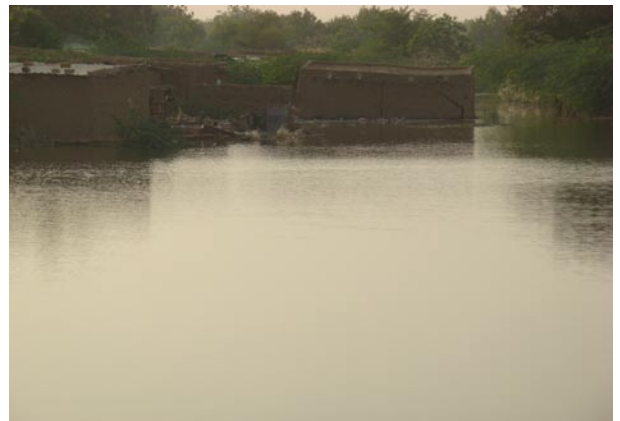
Une vue générale du plan d'eau en plein centre du quartier LAMORDE
