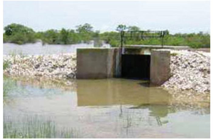
Les différentes techniques mécaniques de lutte contre la salinité : oukine (à gauche); barrage anti-sel avec clapet retour (à droite).
