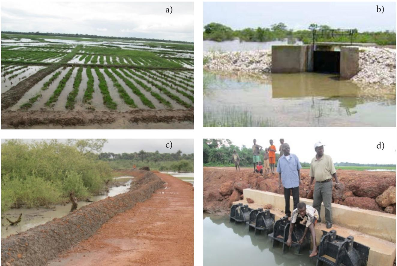
Figure 7 : Les différentes techniques mécaniques de lutte contre la salinité, a) Oukine, b) diguette améliorée, c) barrage anti-sel avec clapet retour
