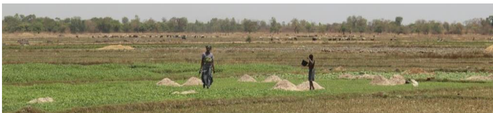
Construction de puits pour pallier à l'insuffisance de l'eau
