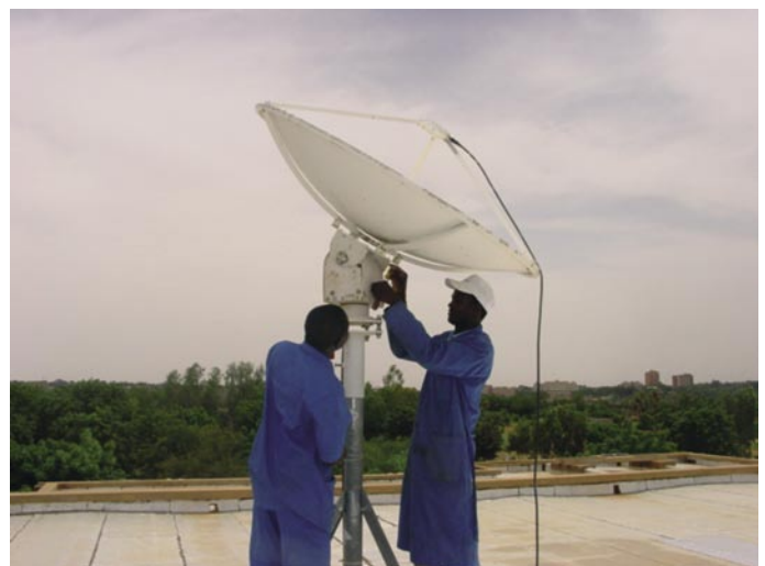
Maintenance de l'antenne de réception du satellite NOAA
