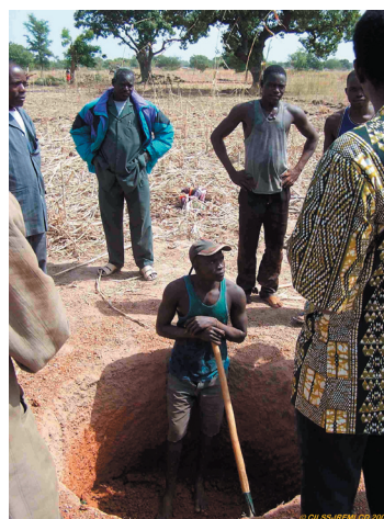
Construction d'un puits
