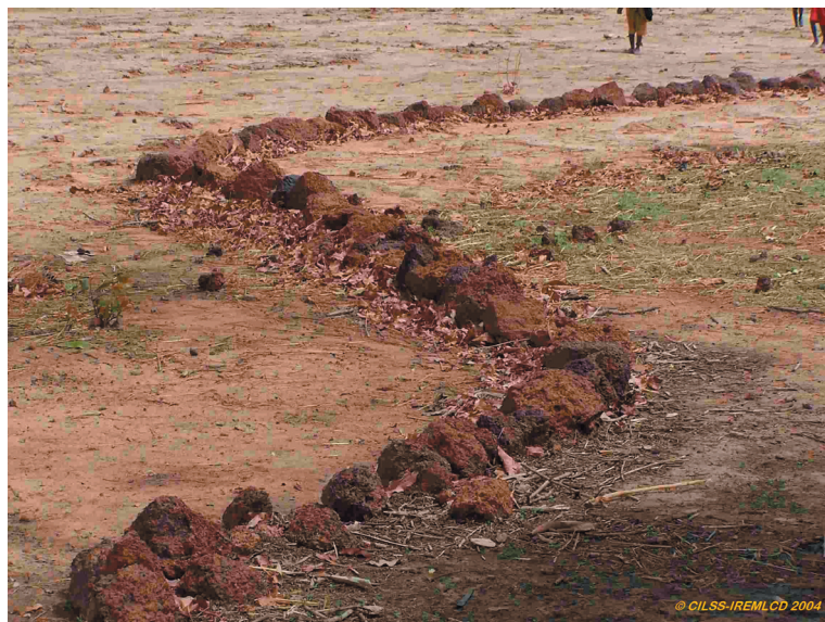
Diguettes anti érosives - Burkina Faso
